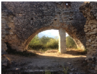
Aqueduc romain de Barbegal (Cl. N. Villermux)
