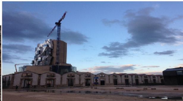
Visite du SITE DES ATELIERS SNCF Fondation LUMA Arles(Cl. N.Villermux)
